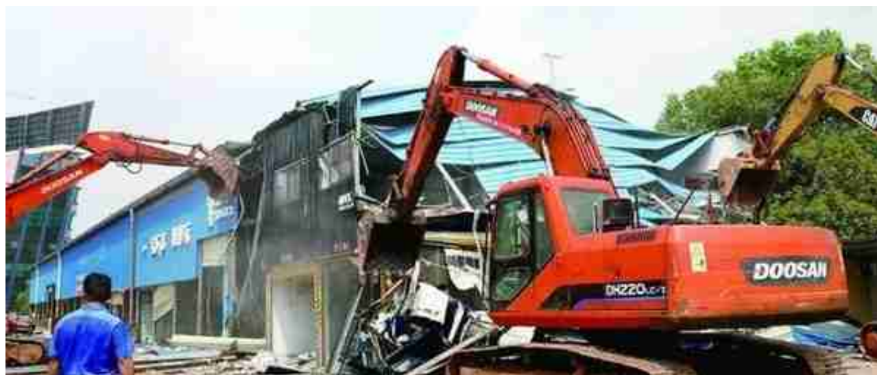
强制清场腾退现场 沈全华/摄
